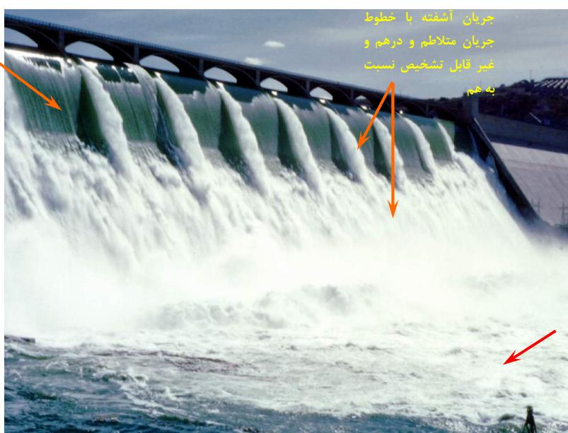
شکل(۷): تبدیل جریان لایه‌ای به جریان آشفته و افزایش اغتشاش جریان در پائین دست آن
