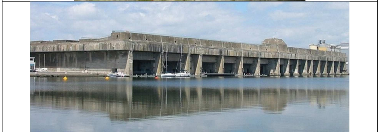
سقف پایگاه «نزایر» با یک فاصله حائل ۴ متری از سقف اصلی بتنی پناهگاه برای مقاومت در برابر بمب‌های چند تنی در حملات هوایی انگلیسی‌ها- ۱۴ ورودی این پناهگاه برای ورود زیردریایی‌ها
