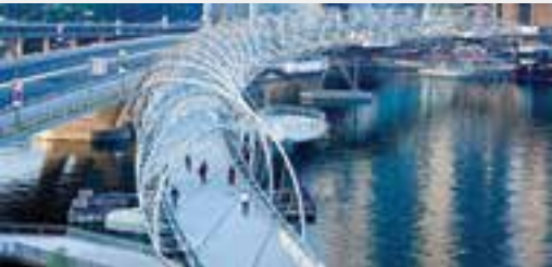
پل هلیکس یکی از سازه‌های ساده ولی جذاب سنگاپور
